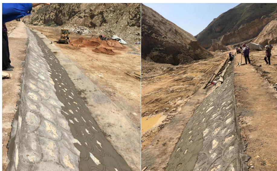
图3-1 浆砌石挡土墙
