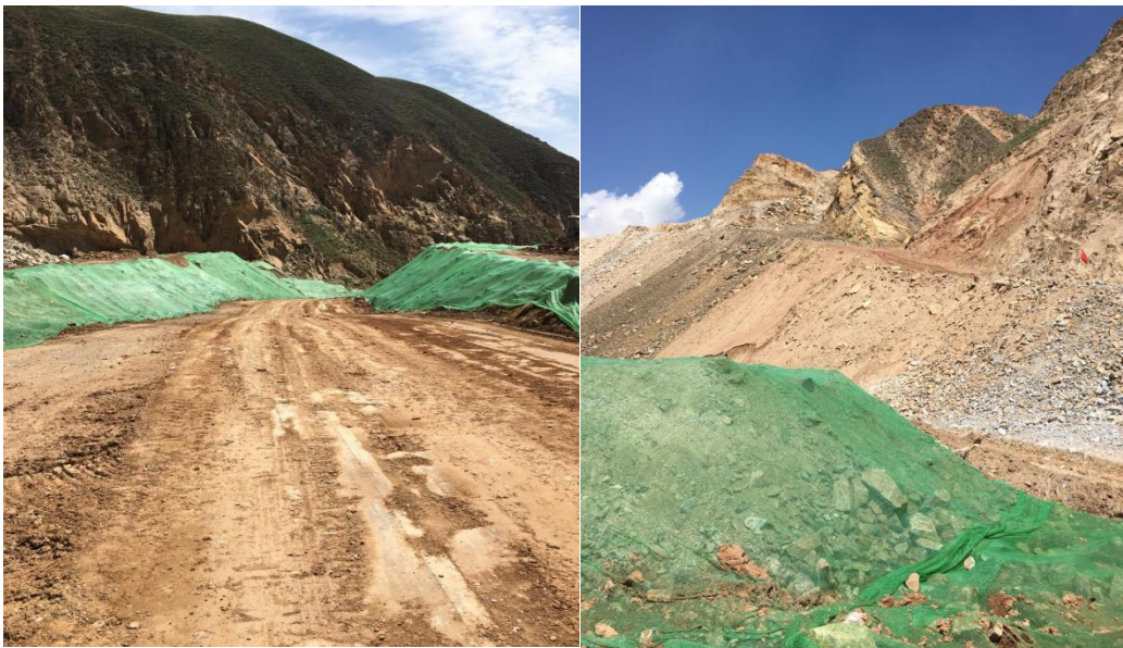
图3-3 道路边坡临时苫盖
