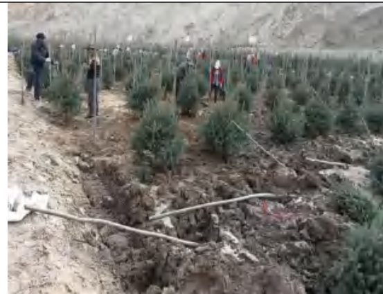
废石场 (施工期)
