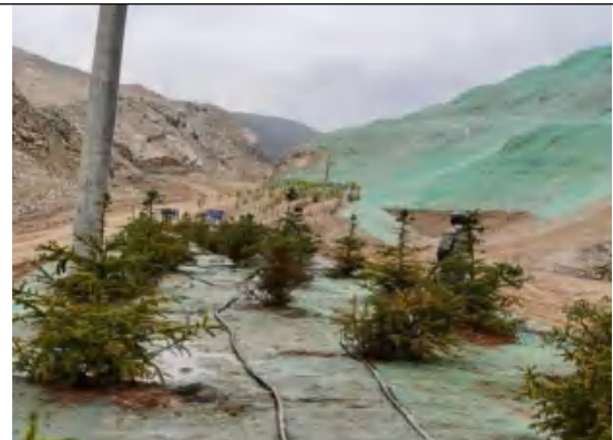
输电线路区植物、临时苫盖
