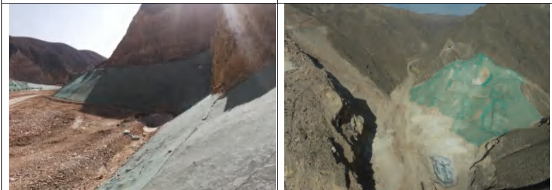
道路区沉砂池现状 (2021.2)
