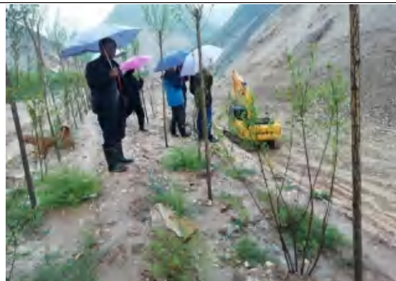
道路区植物措施 (2020.6)
