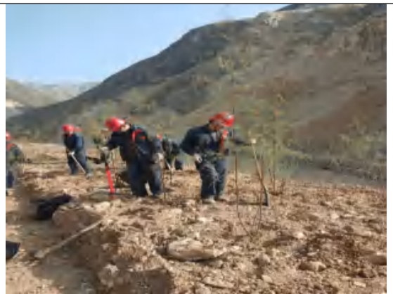
道路边坡植树 (施工期2020.6)
