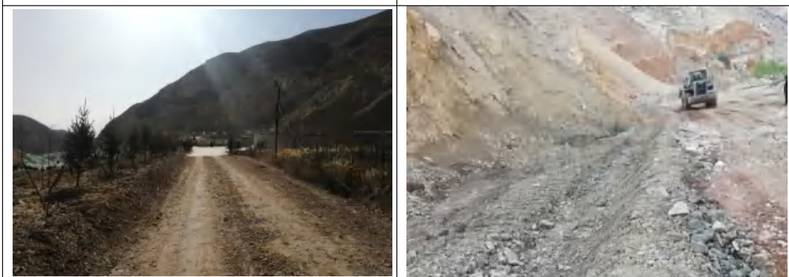
道路区砾石压盖及植被措施现状 (2021.2)
