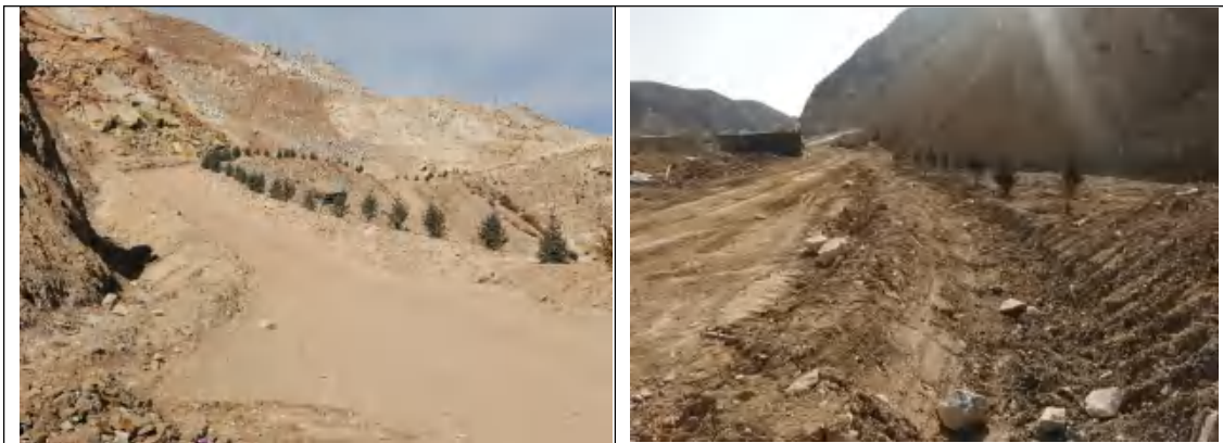
道路区土质排水沟及植被措施现状 (2021.2)
