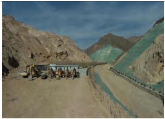
加工场生活区砾石压盖现状 (2021.2)
