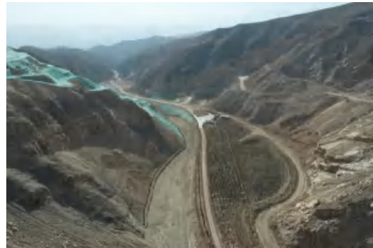
道路区现状（2021.2拍摄）
