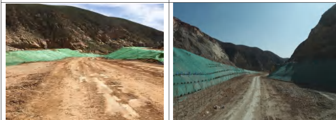
道路区 (施工期)
