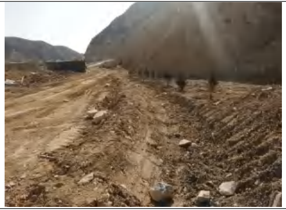
道路区土质排水沟现状 (2021.2)
