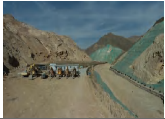
加工场生活区砾石压盖现状 (2021. 2)
