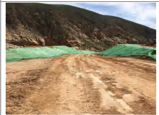
道路区 (施工期)
