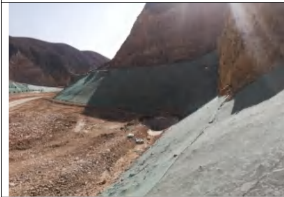
道路区沉砂池现状 (2021.2)
