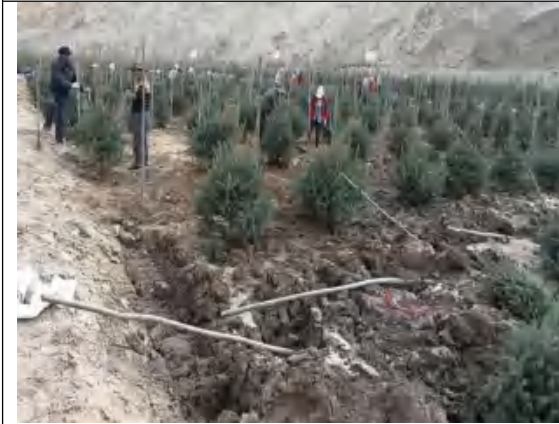
废石场 (施工期)
