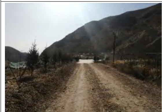
道路区砾石压盖及植被措施现状 (2021.2)
