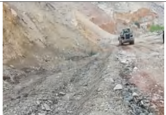
土质排水沟现状 (2021.2)
