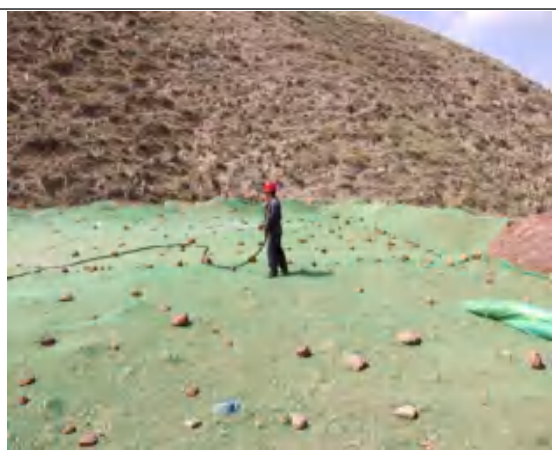
临时苫盖、洒水 (2020.5)
