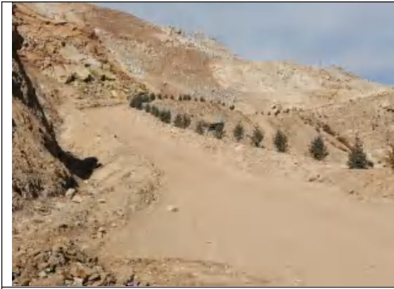
道路区土质排水沟及植被措施现状 (2021.2)
