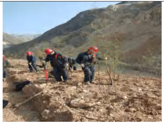
道路边坡植树 (施工期2020. 6)
