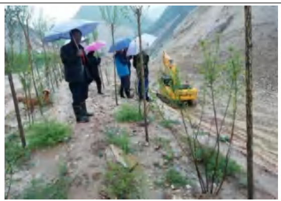
道路区植物措施 (2020. 6)
